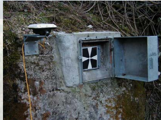
Fig.4 - mira fissa con caposaldo GPS
